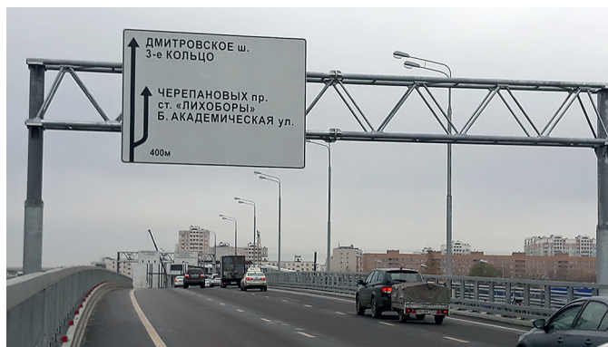
Монтаж конструкций щитов информационного обеспечения автодороги Москва – Санкт-Петербург (Северная Рокада, Москва, 2018 г.)
