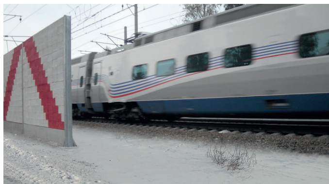
Монтаж шумозащитных экранов при организации скоростного движения поездов «ALLEGRO» (железнодорожная линия Санкт-Петербург-Бусловская-Хельсинки, 2014-2015 гг.)
