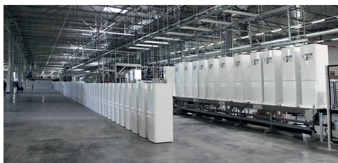
Монтаж конвейерной линии по производству крупногабаритной бытовой техники LG (завод LG Electronics, Московская область, пос. Дорохово, 2010 г.)
