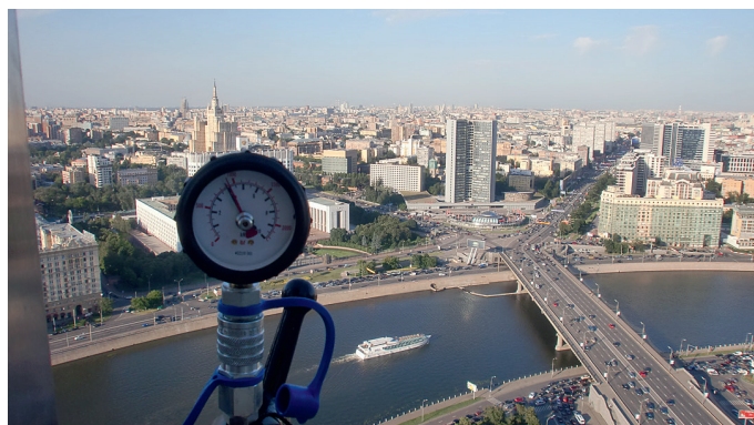
Испытание несущей способности крепления ветрозащитного остекления (гостиница «Украина»/Radisson Royal Moscow, 2010 г.)
