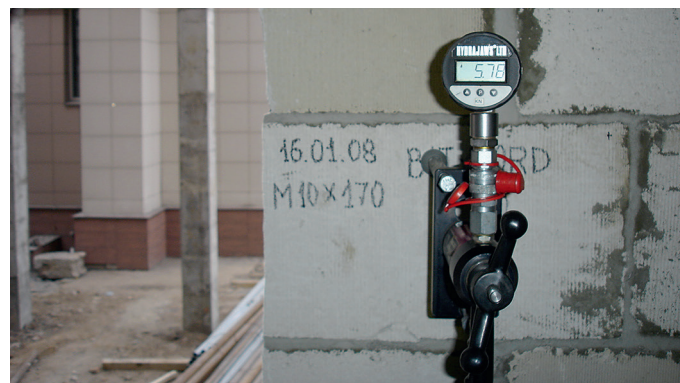
Испытания EASYFIX BIT-NORD в кладке из ячеисто-бетонных блоков (резьбовая шпилька M10, глубина заделки L=170 мм, максимальная нагрузка 5,78 кН)
