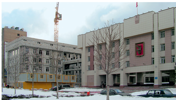
Монтаж кронштейнов фасадной системы с воздушным зазором к кладке стен из ячеисто-бетонных блоков (Центр по работе с населением и организациями Префектуры ЦАО, Москва, 2008 г.)
