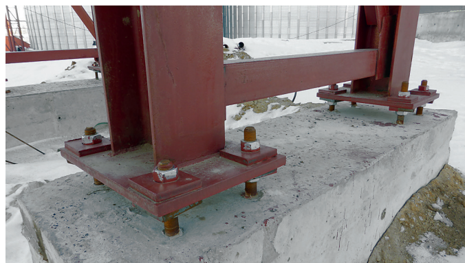
Монтаж металлоконструкций, силосов и элеваторов в зимний период (маслоэкстракционный завод «Содружество-Соя», Калининградская область, г. Светлый, 2012 г.)
