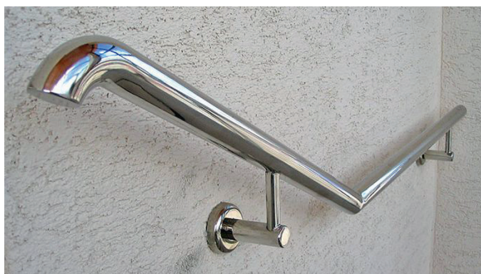
Единственный способ надежного крепления пристенных поручней из нержавеющей стали к стенам из ячеистого бетона (возможность увеличения несущей способности анкера при увеличении глубины его заделки)
