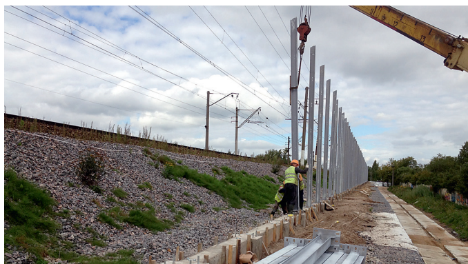
Монтаж металлических стоек шумозащитных экранов к железобетонному ростверку вдоль железнодорожных путей (г. Павловск, 2013 г.)
