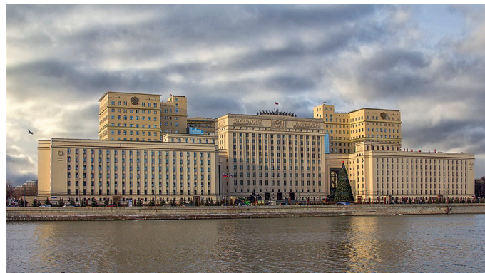
Реконструкция здания Главного штаба сухопутных войск Министерства обороны РФ (крепление восстановленных по оригинальным эскизам элементов декора при ремонтно-реставрационных работах)
