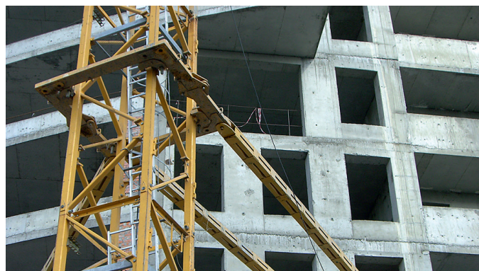
Крепление башенных кранов к перекрытиям и колоннам в высотном строительстве
