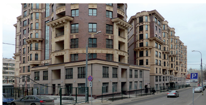
Облицовка фасада архитектурными элементами, выполненными из стеклофибробетона. Площадь фасада 10 000 м 2 (многофункциональное здание, Москва, 2012 г.)
