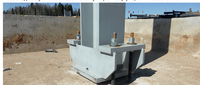
Монтаж колонн здания учебно-демонстрационного центра. Протяженность по фасаду 1560 метров (Военно-патриотический парк культуры и отдыха Вооруженных сил РФ «Патриот», Московская область, г. Кубинка, 2016 г.)
