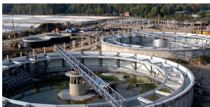
Реконструкция, профилактический и капитальный ремонт очистных сооружений (эксплуатация металлоконструкций в условиях агрессивных сред)
