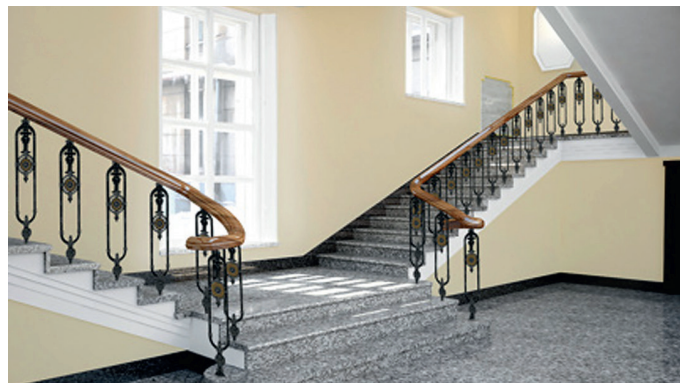
Установка литых чугунных балясин на лестничных маршах, облицованных природным камнем (Главный штаб сухопутных войск РФ, г. Москва, 2014 г.)
