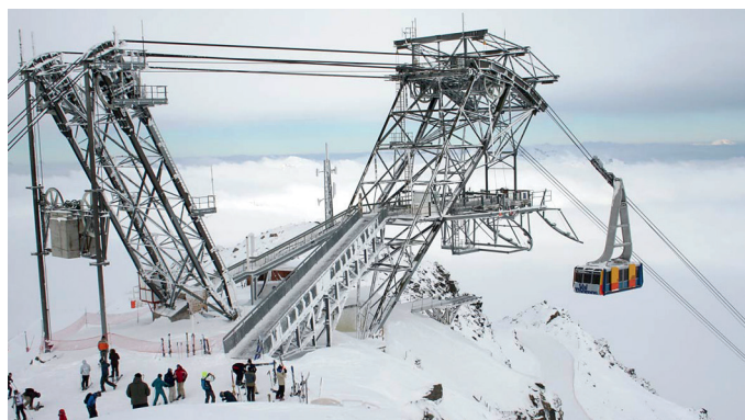
Крепление горнолыжных подъемников, фуникулеров и подъемно-транспортных устройств непосредственно к горной породе в условиях постоянных отрицательных температур
